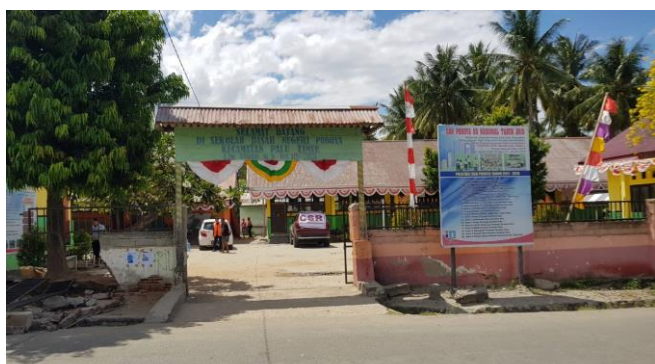
Tinjauan kerusakan SDN Poboya
