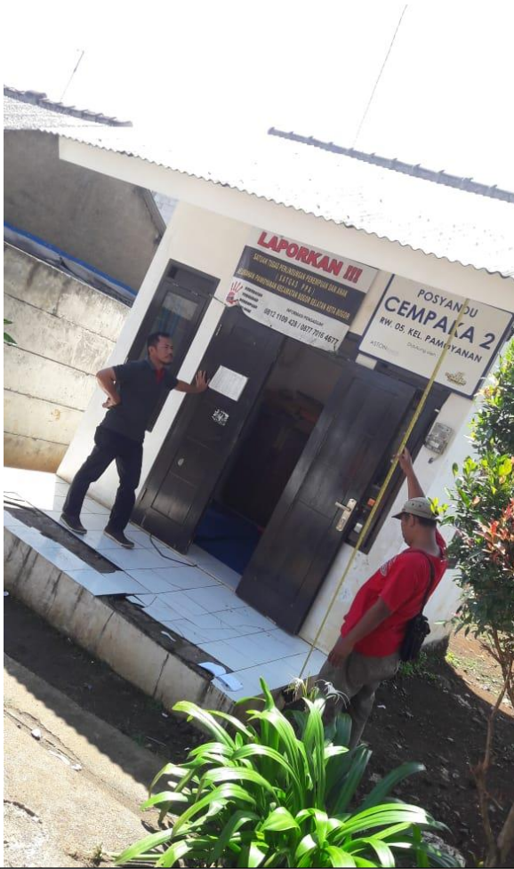
Foto sebelum direnovasi
