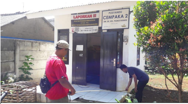
Foto lantai sebelum direnovasi
